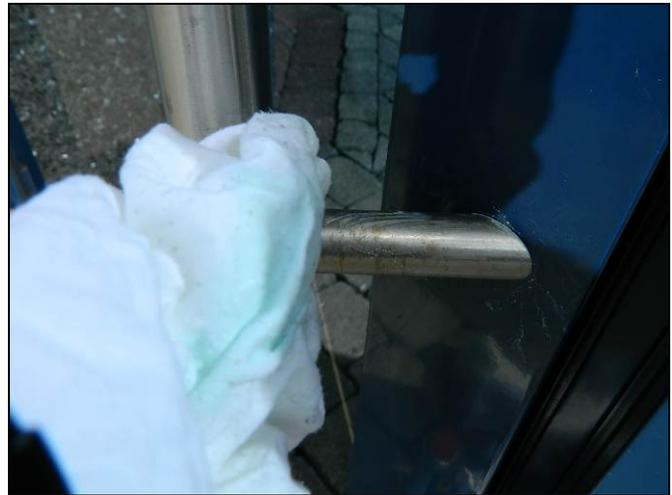
Um das Ergebnis zu schützen, sprühen Sie etwas Universal-Öl (Ballistol oder WD40) auf einen Lappen und reiben die behandelten Flächen damit ab. So bildet Sie hier eine extra Schutzschicht.
